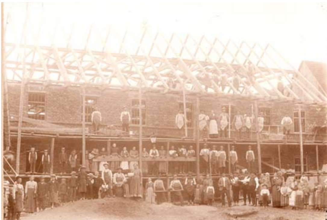
Hebauffeier beim Moar 1906
